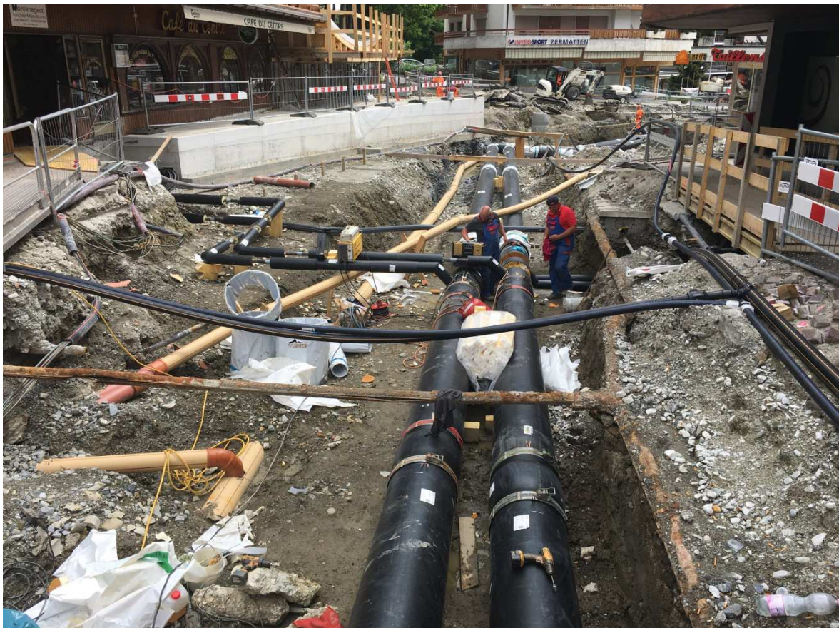
Travaux Rue Théodore Steffany
