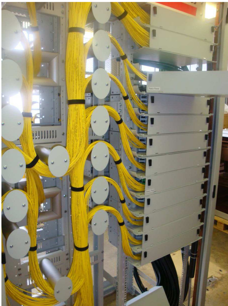
Photo d'un hub - point de concentration où convergent les fibres optiques provenant des domiciles des clients
