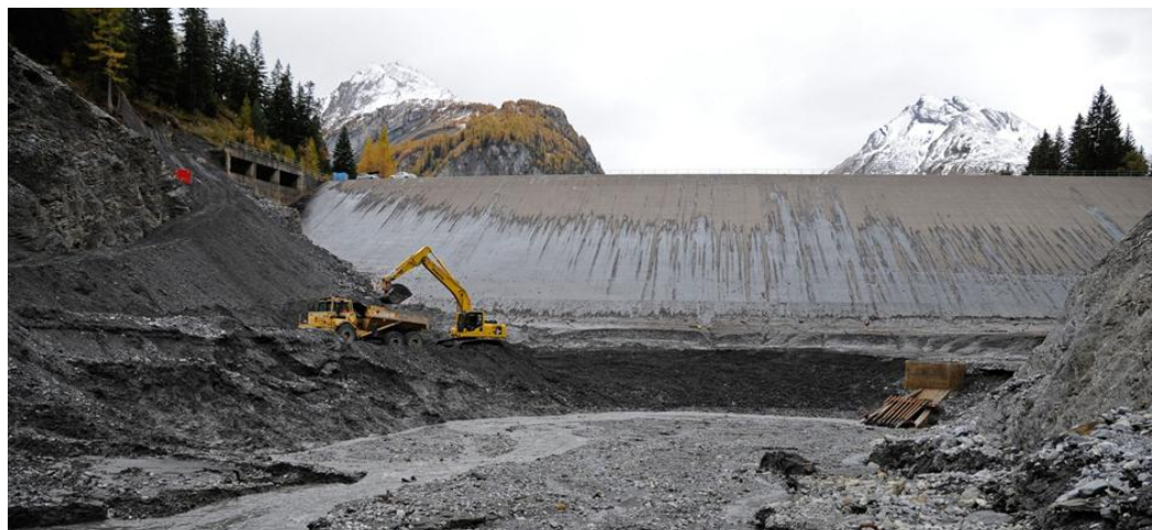
Dégagement de la prise de fond de la retenue du Godey
