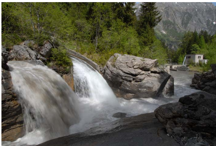
Sortie galerie de la Nétage en amont de la prise d'eau de la Morge
