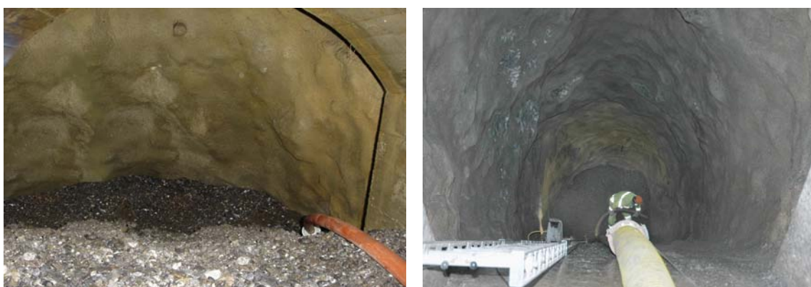
Dégagement de la prise d'eau de la Nétage
