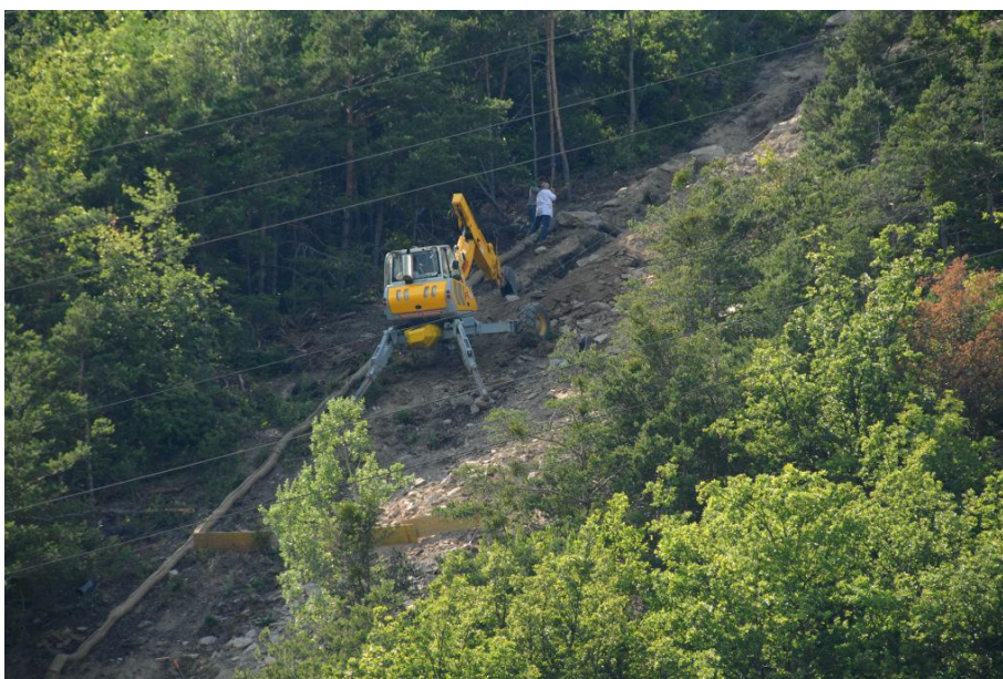
Pose de la nouvelle protection cathodique
