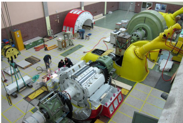
Remplacement du stator de l'alternateur du groupe 1 à l'usine de Croix
