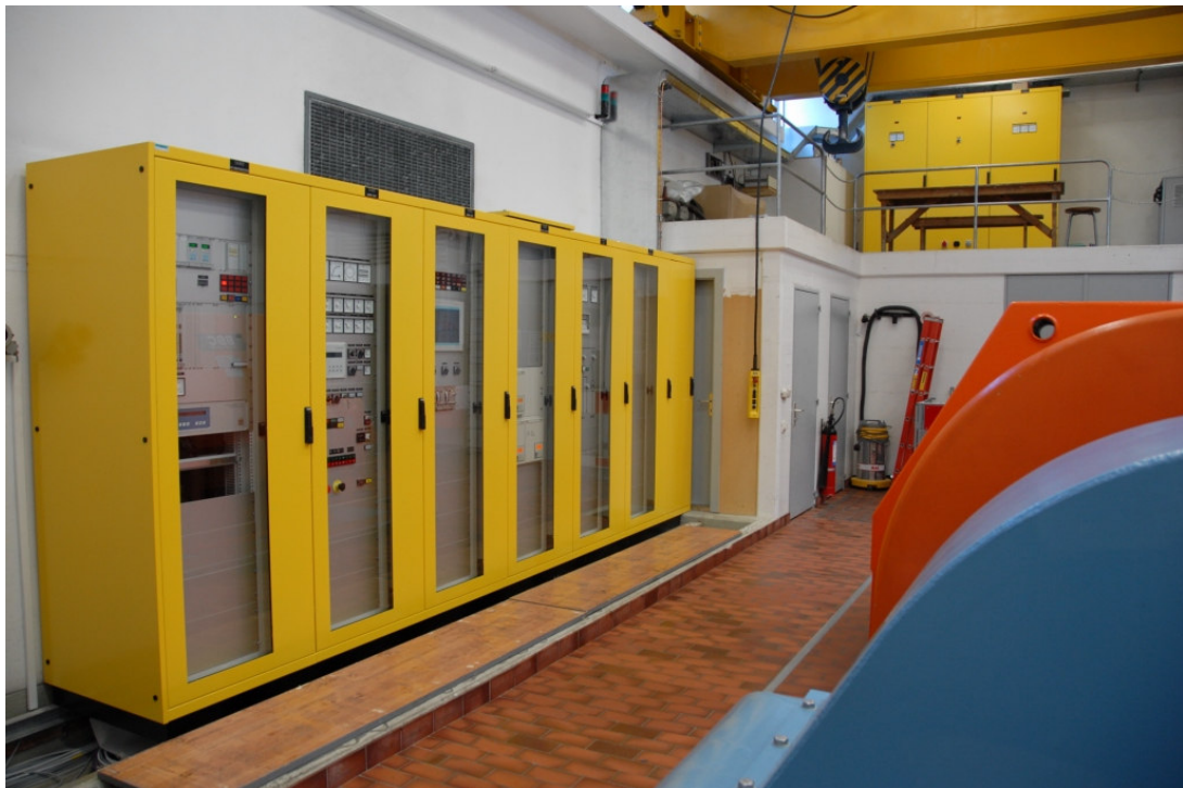
Installation des nouvelles armoires à la centrale
