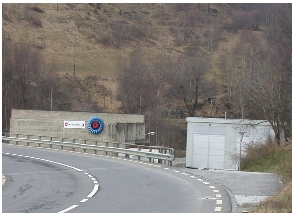
Usine de Sauterot et sous-station 65/16kV d'Euseigne
