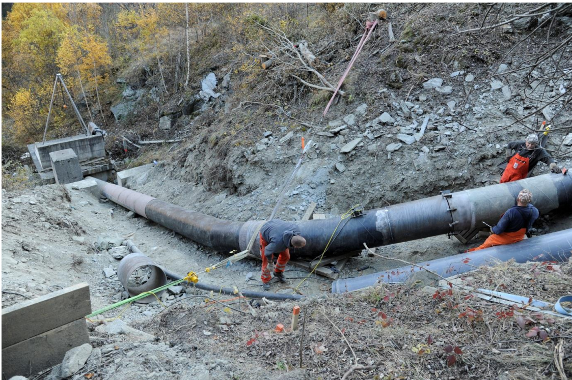
Conduite forcée : alignement et soudage d'un nouvel élément
