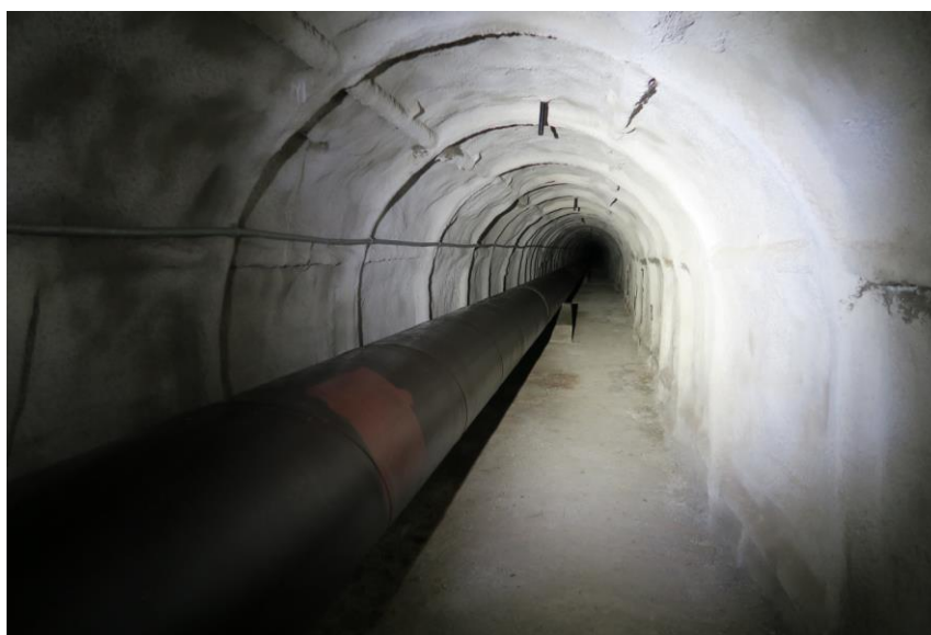
Tronçon en galerie de la conduite forcée
