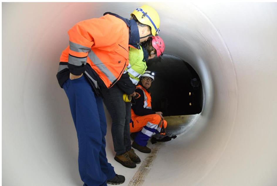
Nouveau revêtement anticorrosion du canal de vidange de la retenue du Godey : réception des travaux
