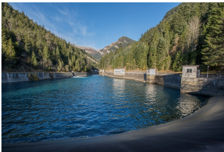
Bassin de compensation de Croix
