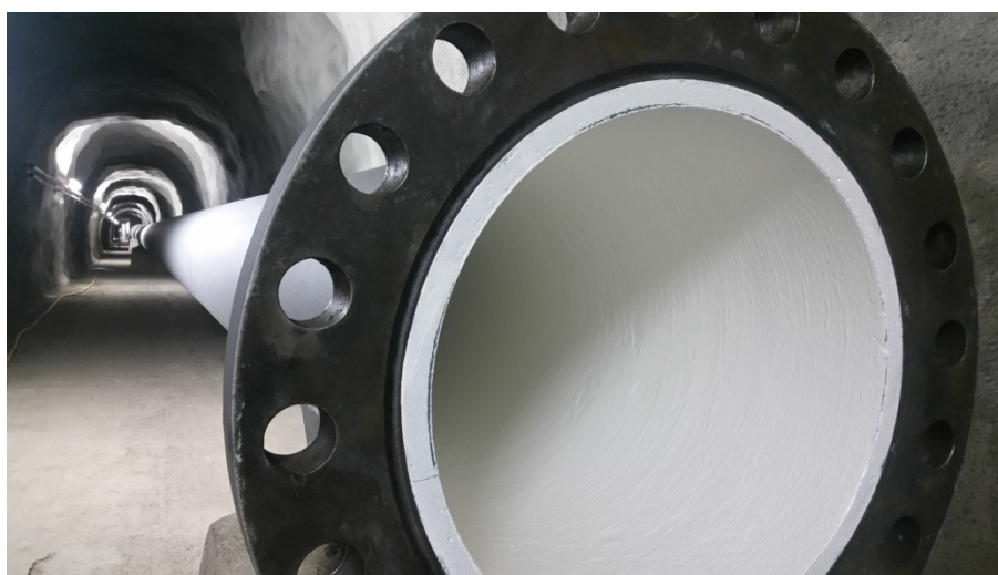
Conduite forcée de Chamarin : Renouvellement de la protection anticorrosion
